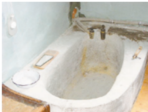
Kurz, aber tief: die aufgemauerten Wannen
